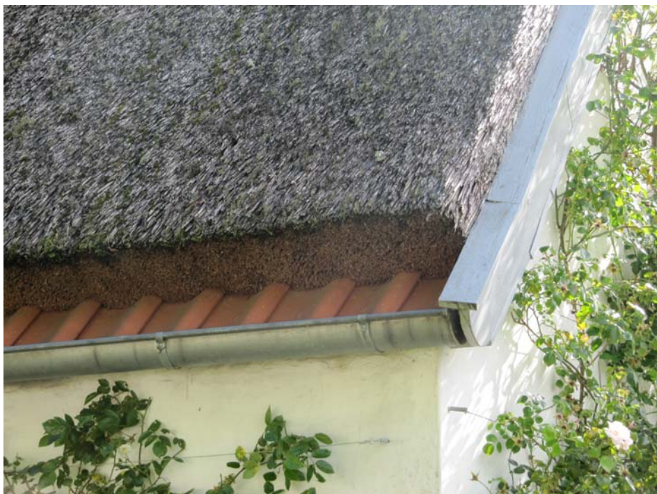
Stråtaget afsluttes her i tagdryp med en række tegl. Bemærk detaljen med vindskedens afrunding, som følger tagrendens afslutning.
