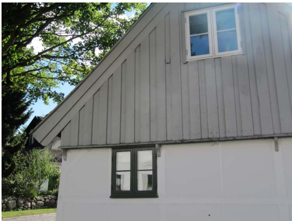
Bræddebeklædningen er udført med ét på to og med vindskede og nedre vandbræt.
